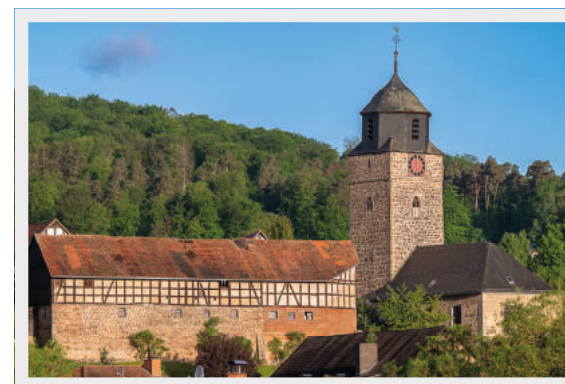
Die Martinskirche im älteren Ortsteil
